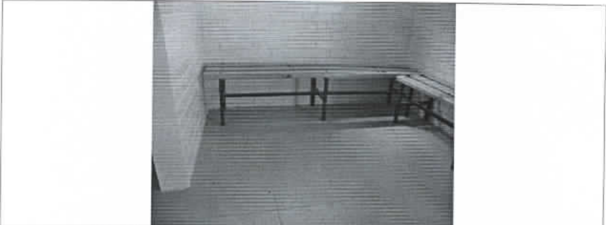
Foto N° 19: camarines sin los guardapolvos de pino \frac{1}{2} " x 2".
